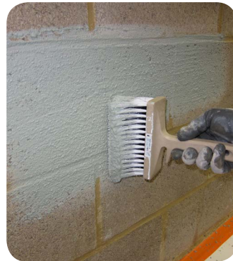
2. Aanbrengen van de cementbrij (handmatig of met spuit)
