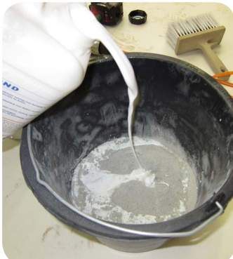
1. Bereiding van de cementbrij
