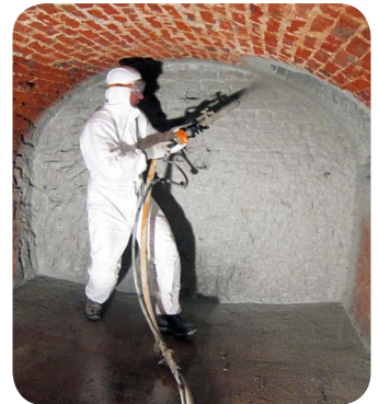
2. Aanbrengen van de cementbrij (handmatig of met spuit)
